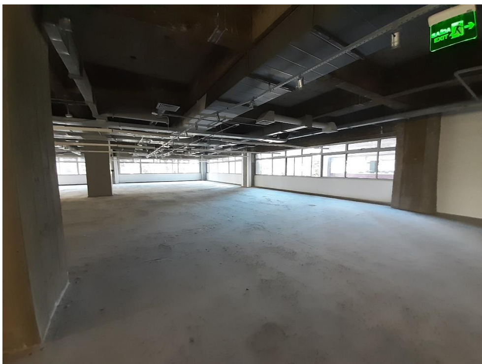
Vista do pavimento tipo
