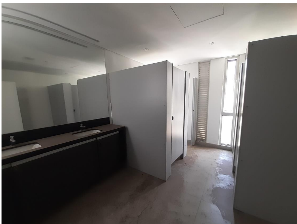
Vista do pavimento tipo
