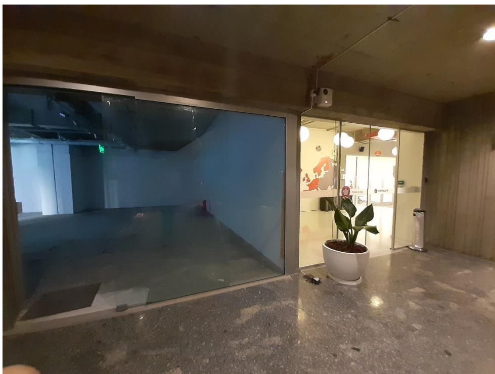
Vista do pavimento tipo
