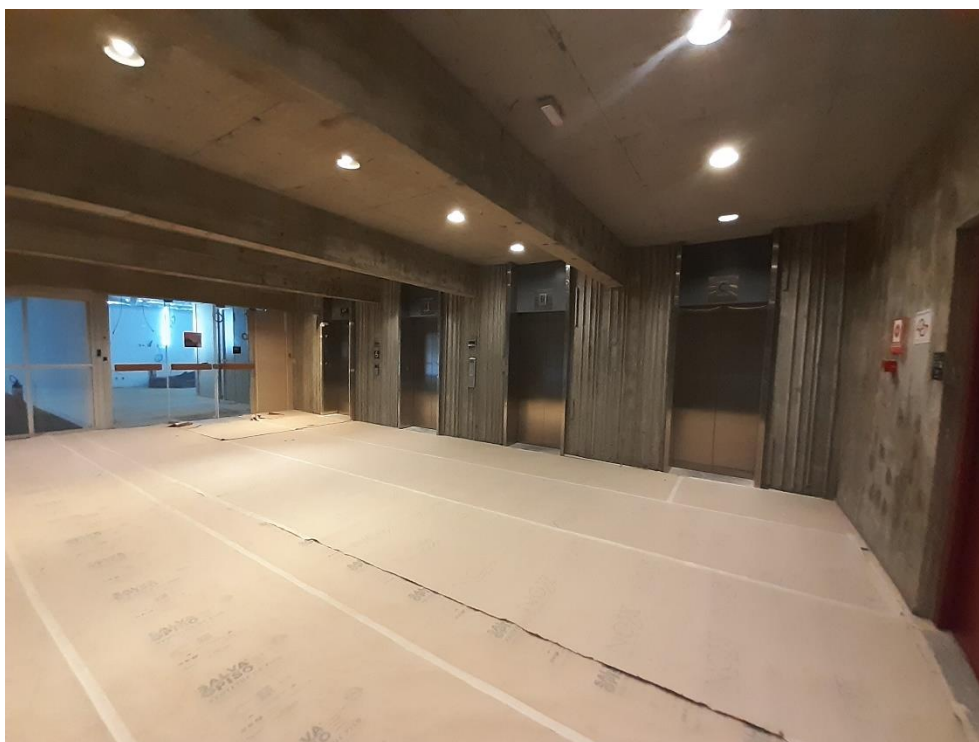
Vista do pavimento tipo
