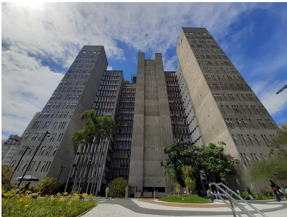
Vista do acesso ao imóvel pela Rua Prof. Geraldo Ataliba
