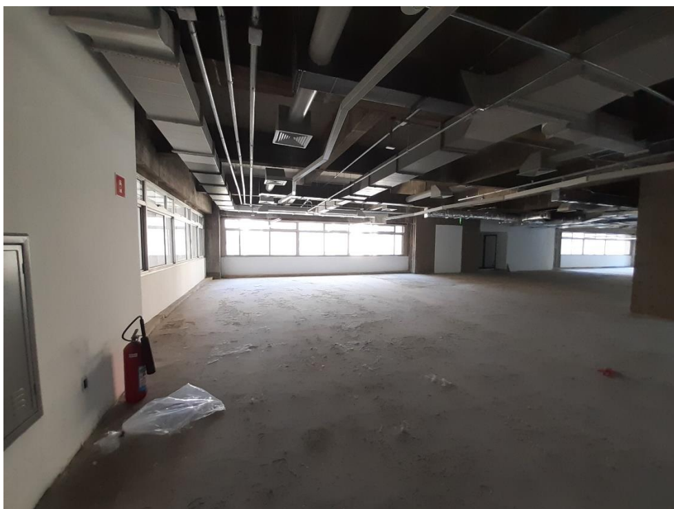
Vista do pavimento tipo
