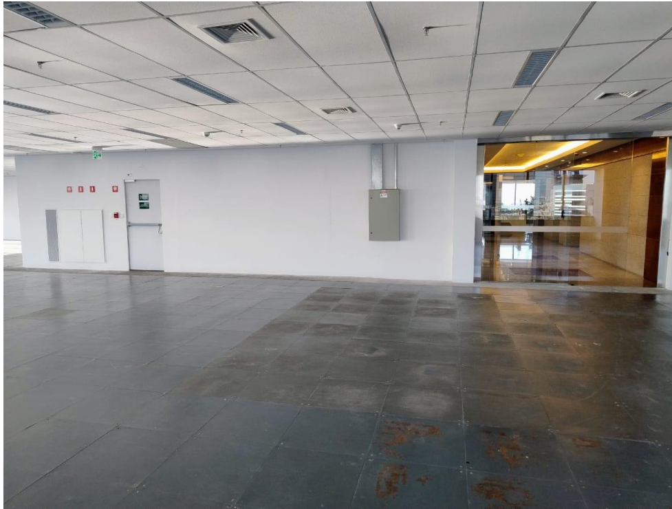
Acesso do pavimento tipo
