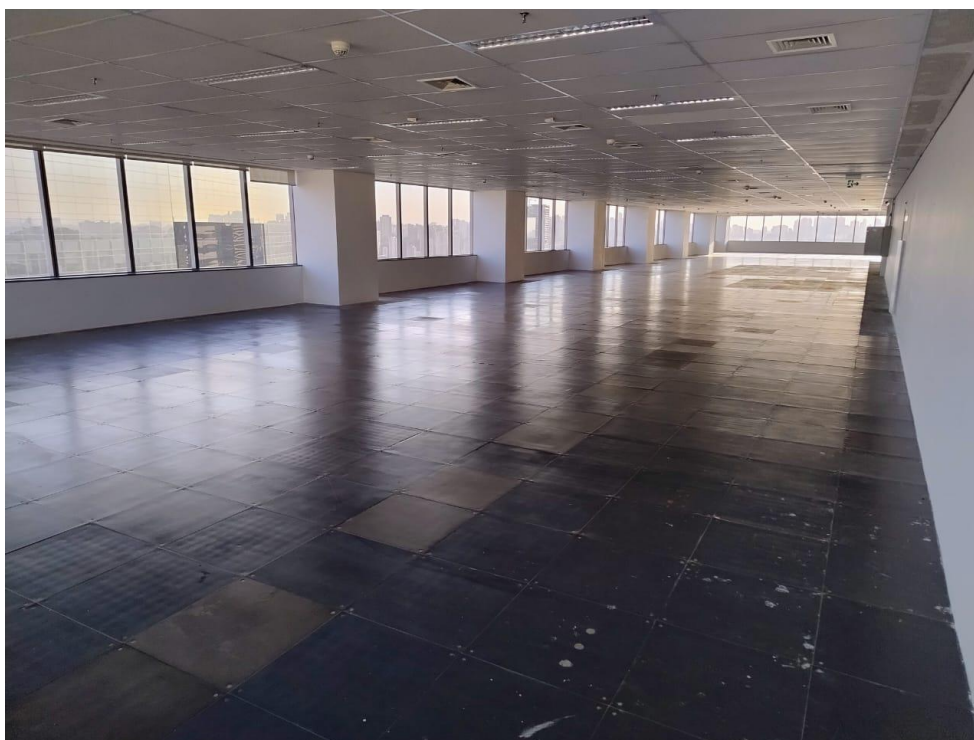
Vista geral do pavimento tipo
