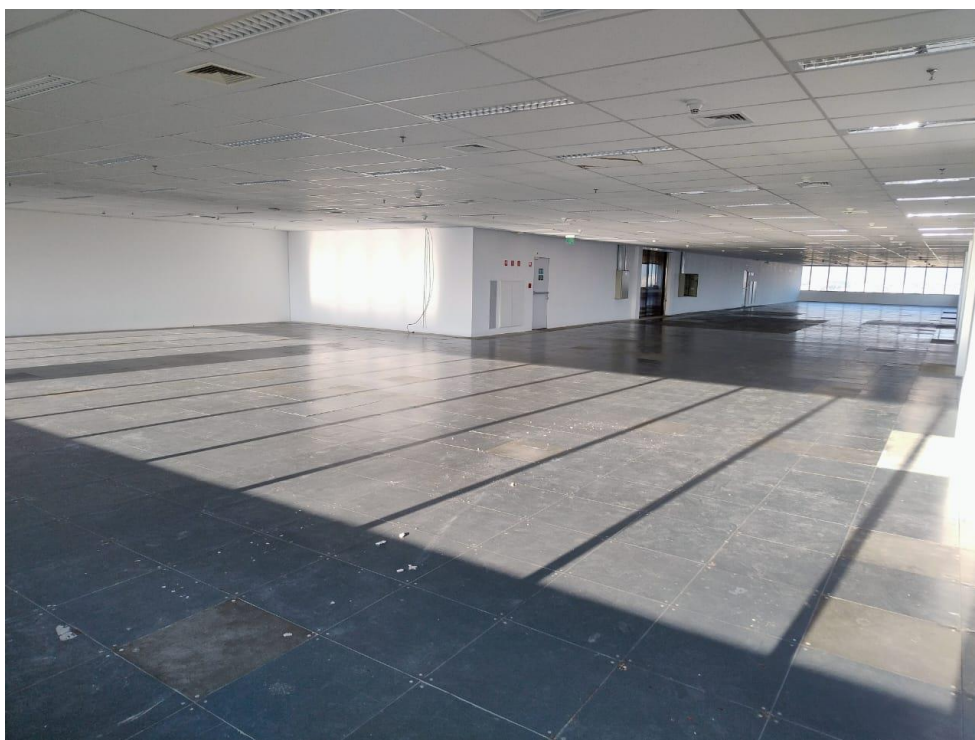
Vista geral do pavimento tipo
